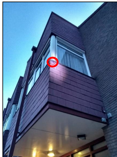
Figuur 4. Zomerverblijfplaats gewone dwergvleermuis met invliegopening onder rand van gevelbetimmering.
