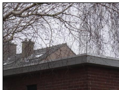
Figuur 18. Mogelijke ruimte tussen gevel en kantpan van direct naast de onderzoekslocatie gelegen woning.
