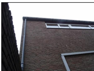
Figuur 26. Aanwezigheid dakgoot rondom woning (nummer 5).
