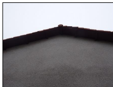
Figuur 21. Ruimte tussen gevel en kantpan open schuur (nummer 4).
