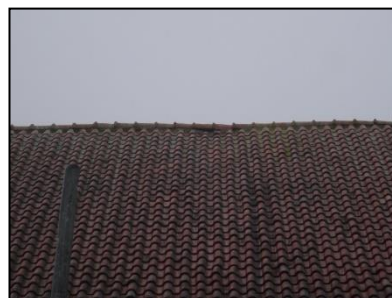
Figuur 24. Zichtbare ruimte onder de dakpan van de open loods (nummer 3).
