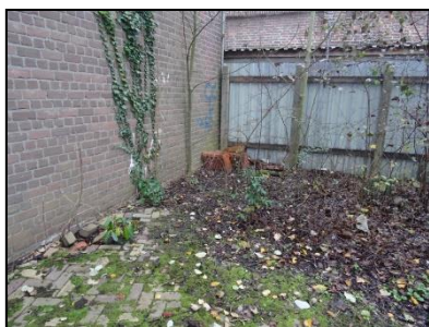
Figuur 10. Oostelijke kopgevel van de gelijkvloerse open loods (nummer 3).
