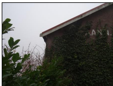
Figuur 19. Ruimte tussen overkapping en kantpan oude loods (nummer 2).
