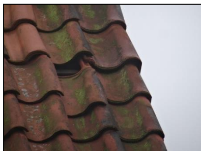
Figuur 22. Ruimte onder de dakpan achterzijde woning (nummer 1).
