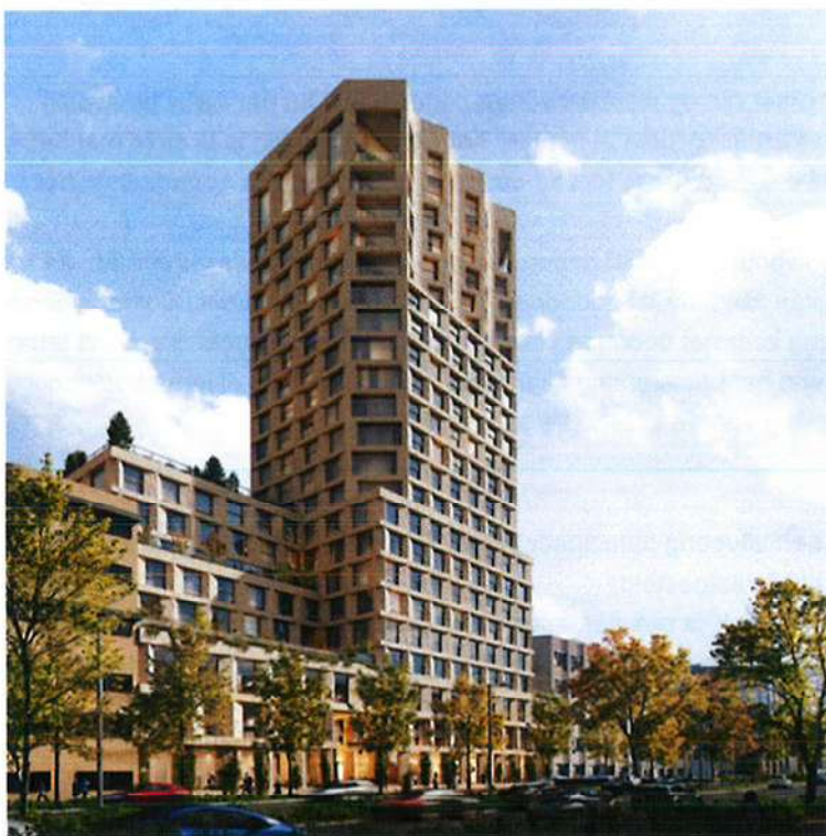
Zicht op het bouwplan vanaf de Schipholweg
