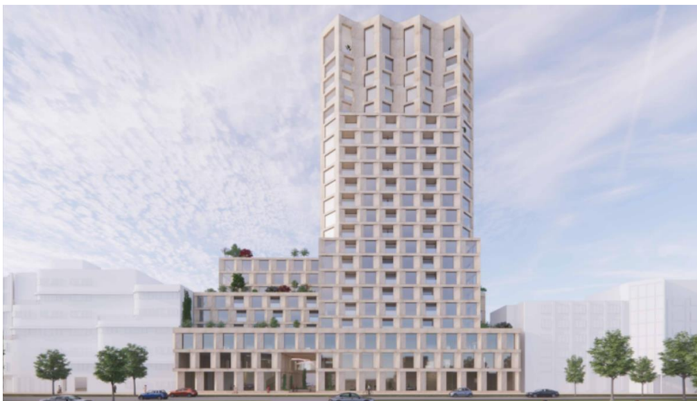
Afbeelding 3a: Gevelaanzicht Schipholweg.
