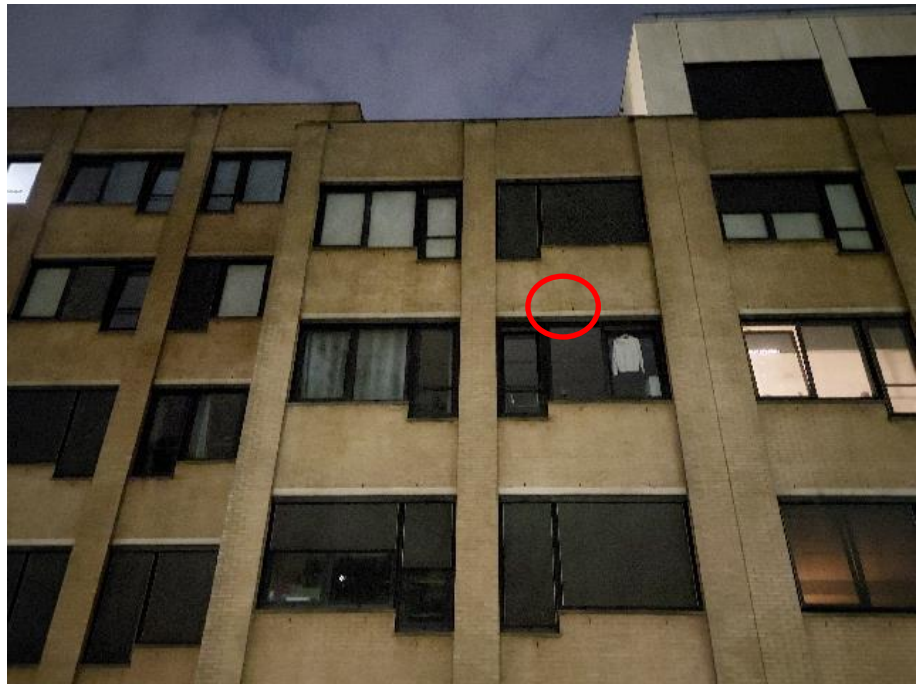
Paarverblijfplaats aan de achterzijde van het gebouw
