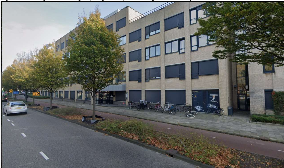
Figuur 3. Huidige bebouwing in plangebied (bron: Google Streetview).
