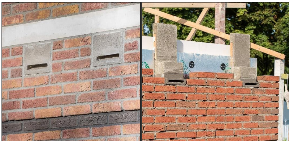
Figuur 7: Voorbeeld van inmetzelstenen (bron: Vivarapo).
