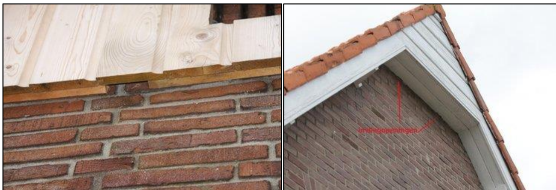
Figuur 8: Voorbeeld van toegankelijke boeiboorden (links) en nokvorst (rechts).
