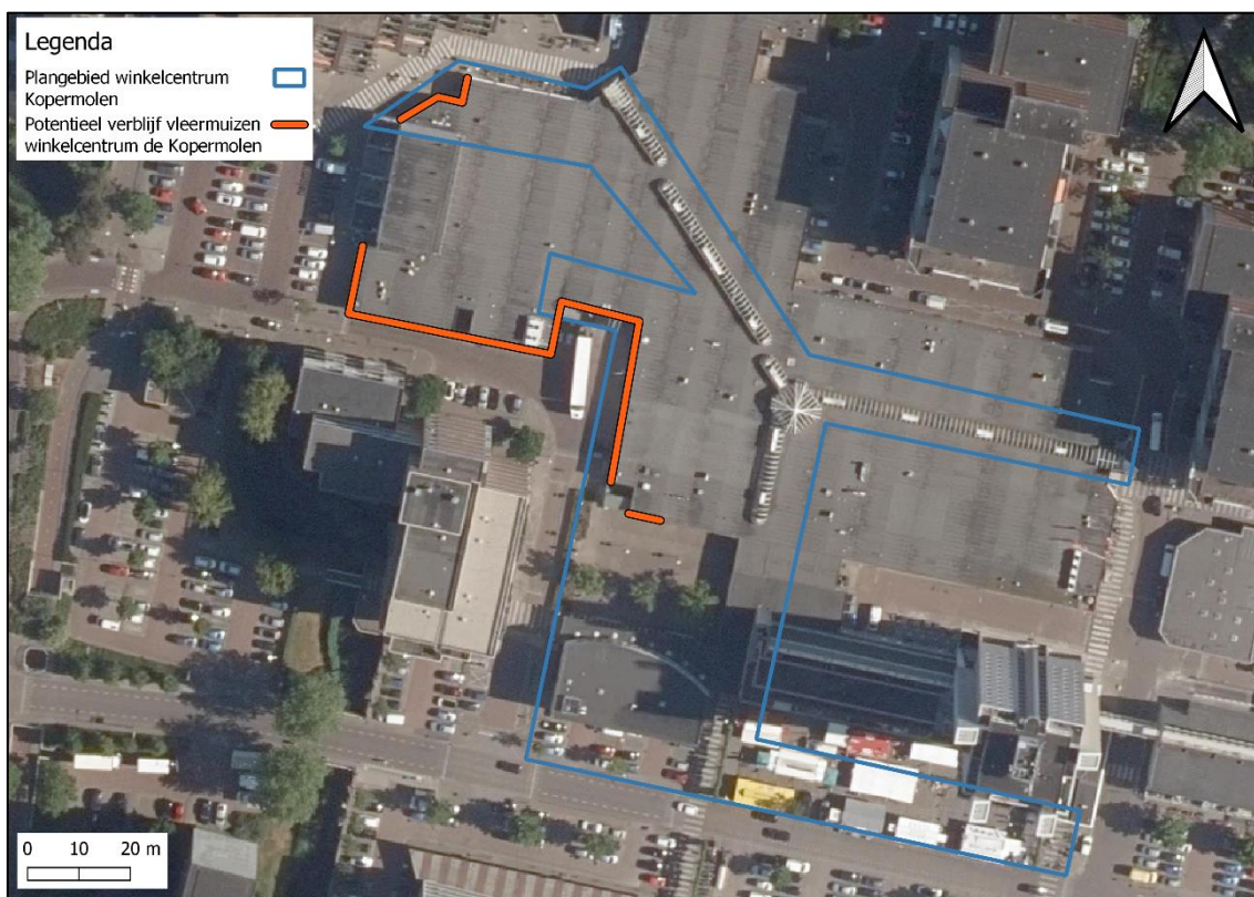
Figuur 22: Locatie open stootvoegen die dwergvleermuizen kunnen gebruiken als verblijfplaats.
