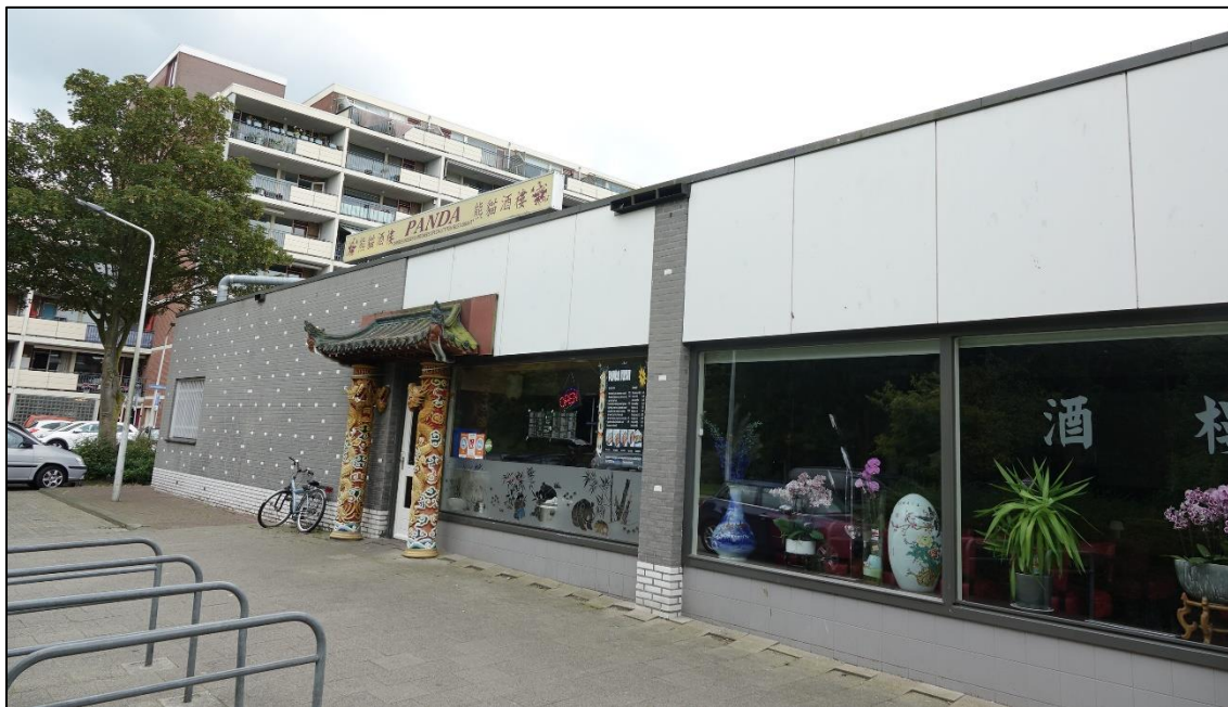
Figuur 7: Noordzijde van het winkelcentrum welke gesloopt zal worden met in de huidige situatie een Chinees restaurant.
