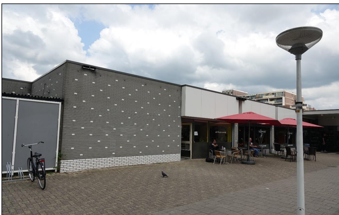
Figuur 4: Te slopen deel van het winkelcentrum waar op dit moment een snackbar in gevestigd is.
