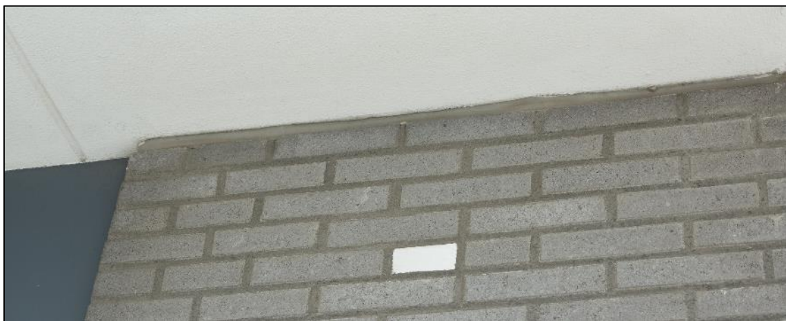
Figuur 35: Goed sluitende gevels en overkapping aan de zuid- en oostgevel.
