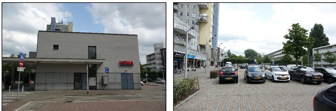
Figuur 2: Hema welke gesloopt zal worden links en het parkeerterrein recht.
