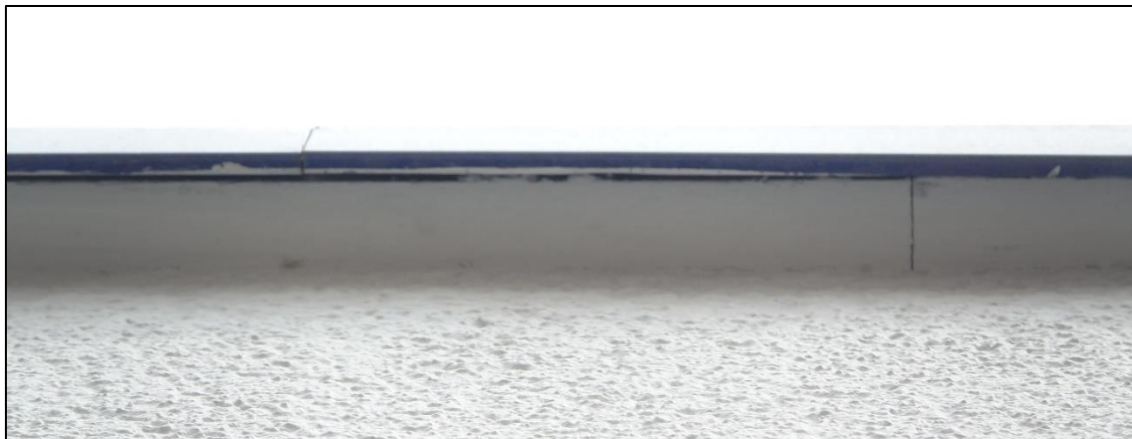
Figuur 19: Gepleisterde muur van de Hema met overhangende dakrand waar geen ruimte achter aanwezig is voor beschermde soorten.
