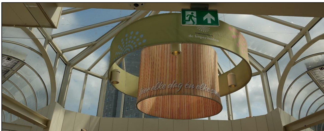
Figuur 16: De passagekap van binnenuit met kunststof platen en metalen constructie.
