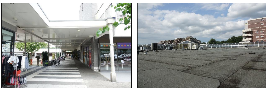
Figuur 3: Links de droogloop en rechts de passagekap welke beide gesloopt zullen worden.
