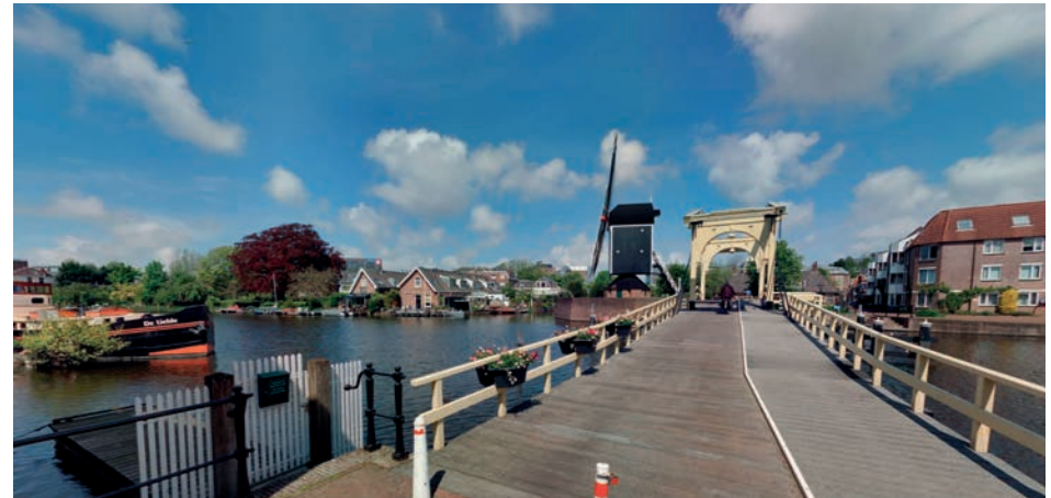
Zicht op molen De Put vanaf de Rembrandtbrug over het Galgewater. (Bron: Cyclomedia)
