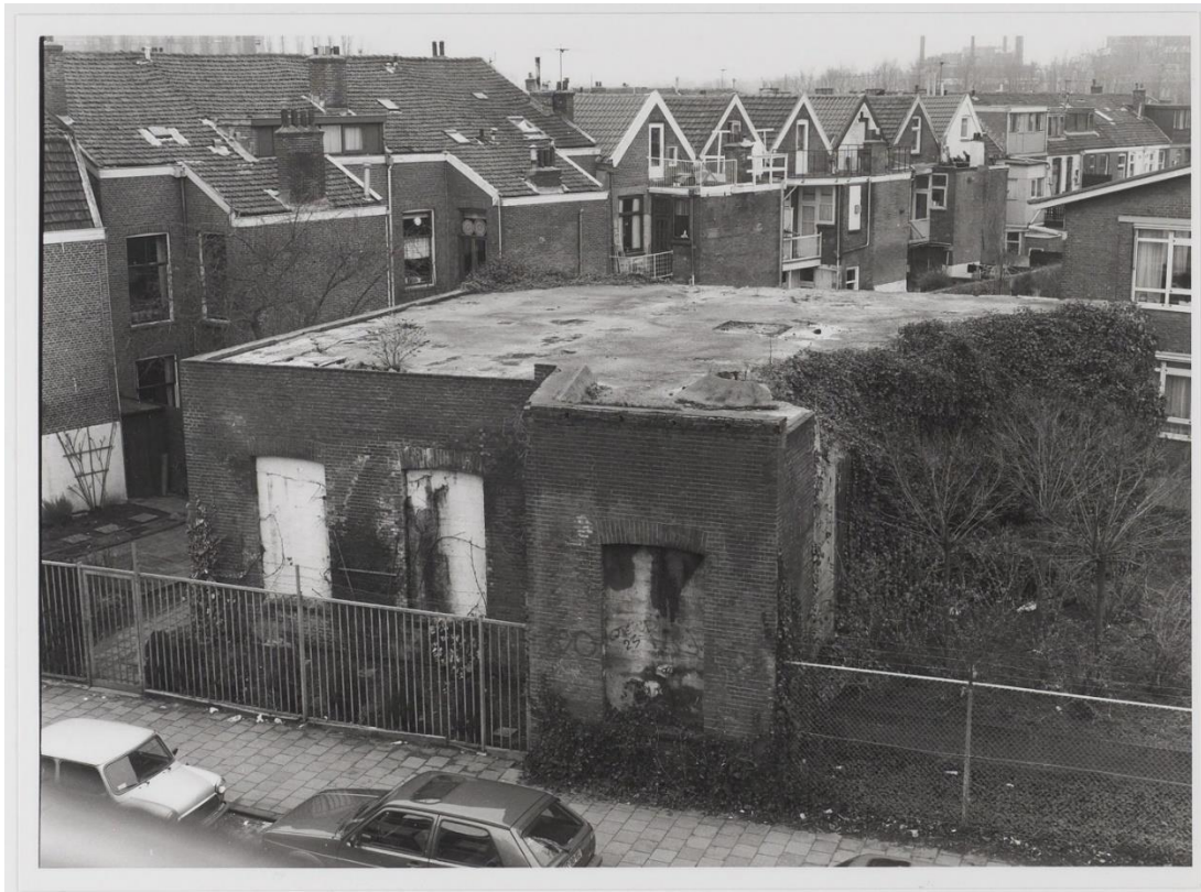
Figuur 17. Foto van de bunker in het plangebied genomen in maart 1994 (PV38167, Collectie Erfgoed Leiden en Omstreken).
