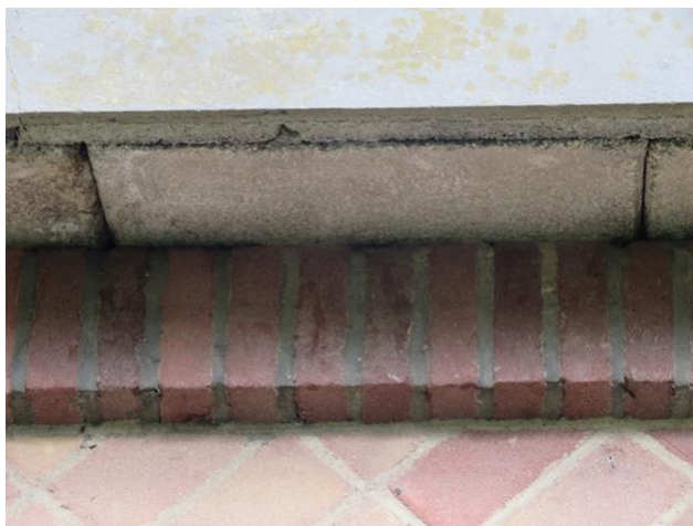
Afbeelding 8A en B: Daklijst P.J. Blokstraat
