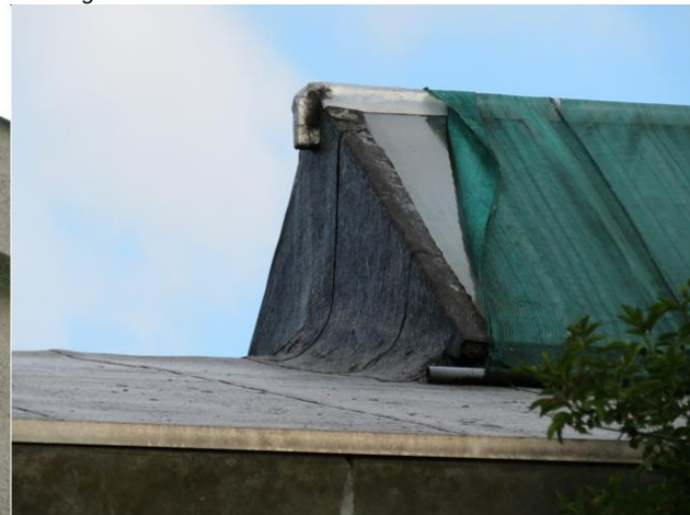
Achtergevel met bitumen bekleed
