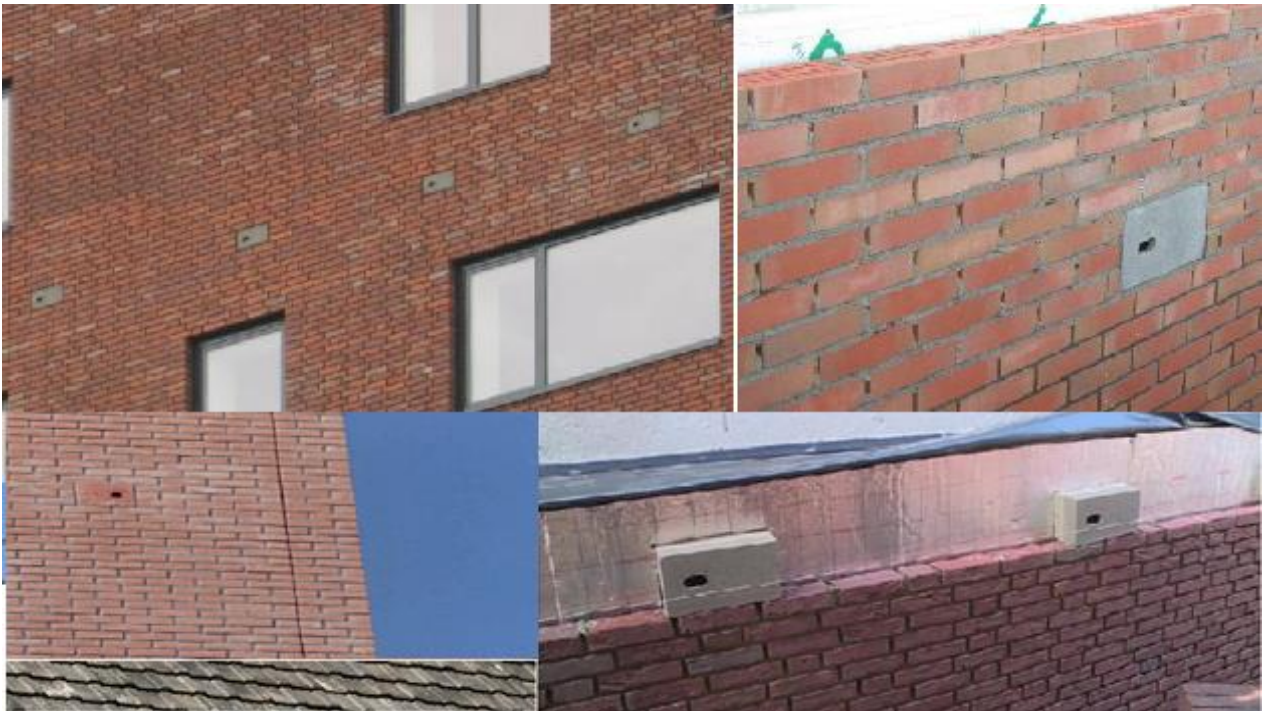
Afbeelding 11A-D: Vrijwel onzichtbare inbouw van vleermuisstenen
