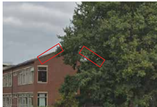
Figuur 3.3: Twee verblijfplaatsen zuidwestgevel, gebouw 2 (deels achter de boom).
