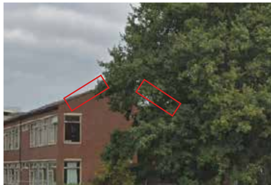
Figuur 4.3: Twee verblijfplaatsen zuidwestgevel, gebouw 2 (deels achter de boom).
