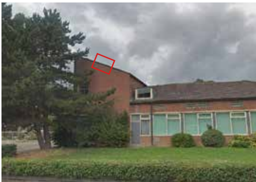
Figuur 4.2: Verblijfplaats zuidoostgevel, gebouw 1.
