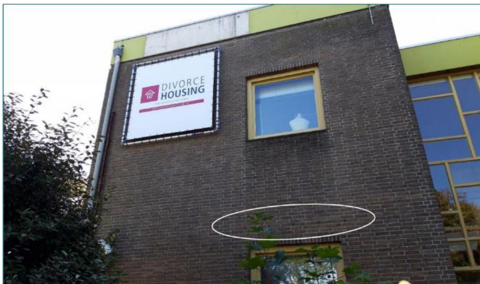
Figuur 2 Stootvoegen boven het onderste raam (witte cirkel). (Foto: RHDHV, 2020)
