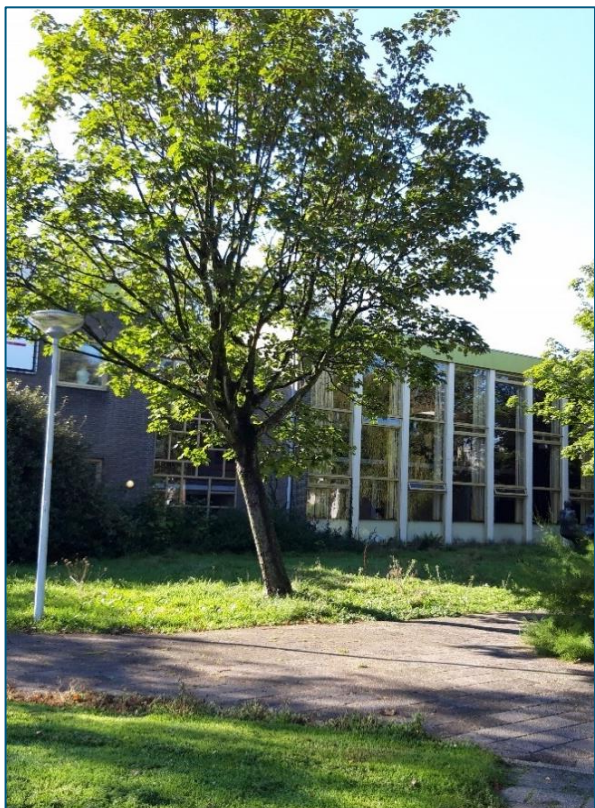
Figuur 2-2. Noordgevel van het gebouw. (Foto: RHDHV, 2020)
