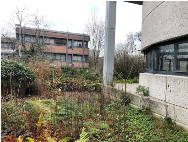
Fotonummer 1: Oostzijde onderzoekslocatie.
