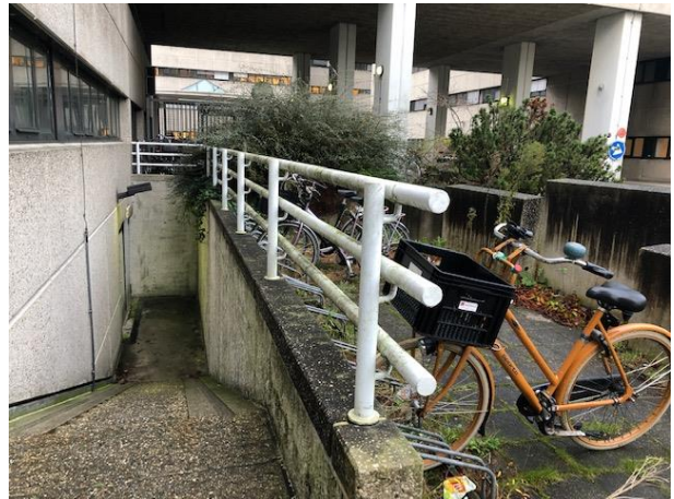
Fotonummer 2: Oostzijde onderzoekslocatie.
