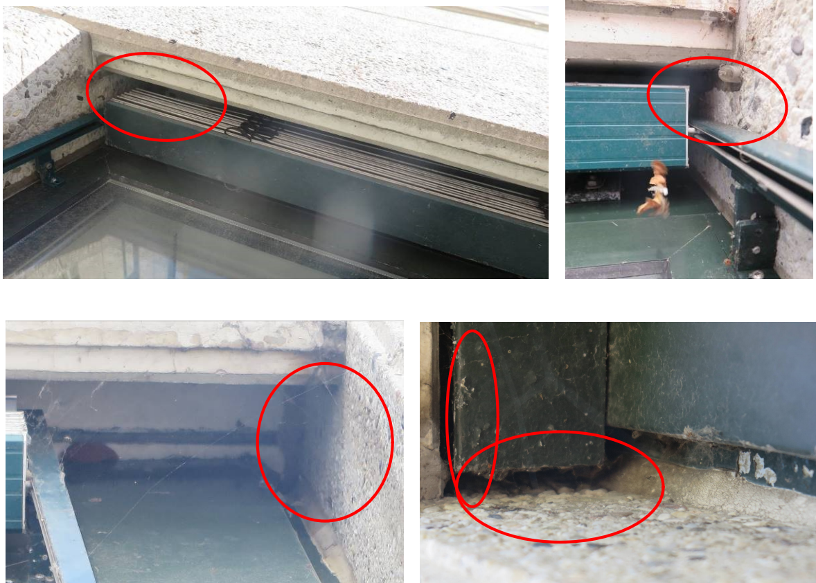
Figuur 4. Potentiele openingen voor vleermuizen in de raampartijen aan de Plesmanlaan 100 te Leiden.
