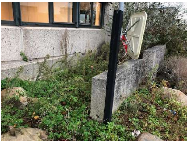
Fotonummer 5: Oostzijde onderzoekslocatie.
