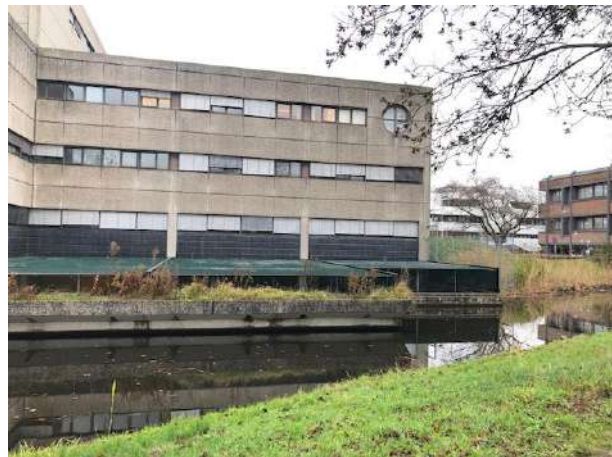
Fotonummer 14: Zuidzijde (achterkant) onderzoekslocatie.
