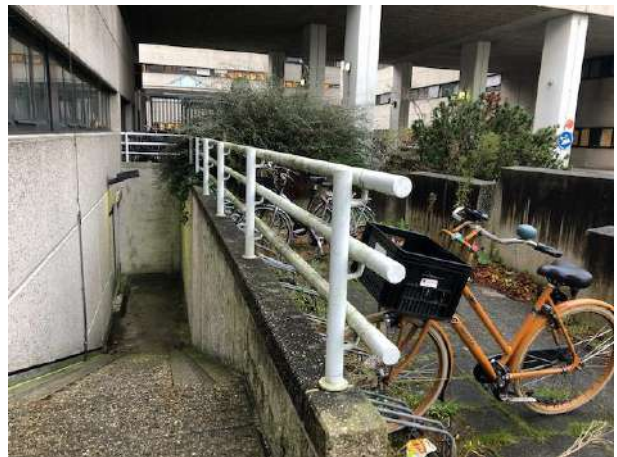
Fotonummer 2: Oostzijde onderzoekslocatie.
