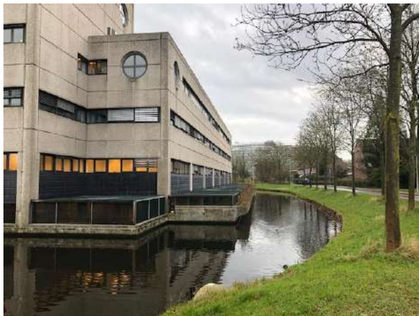
Fotonummer 13: Zuidzijde (achterkant) onderzoekslocatie.
