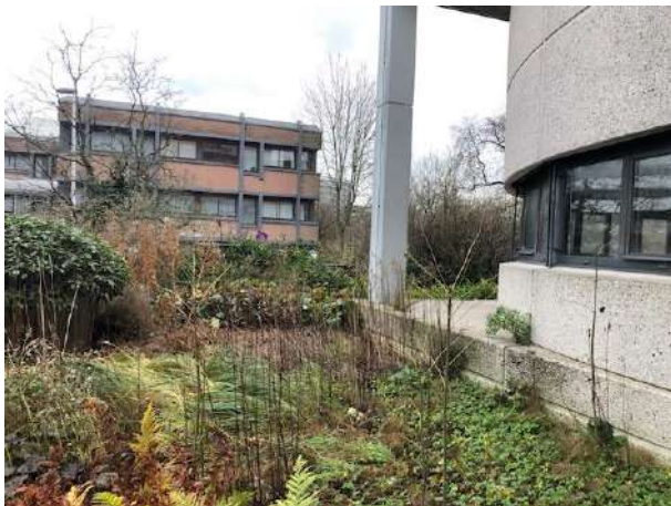
Fotonummer 1: Oostzijde onderzoekslocatie.
