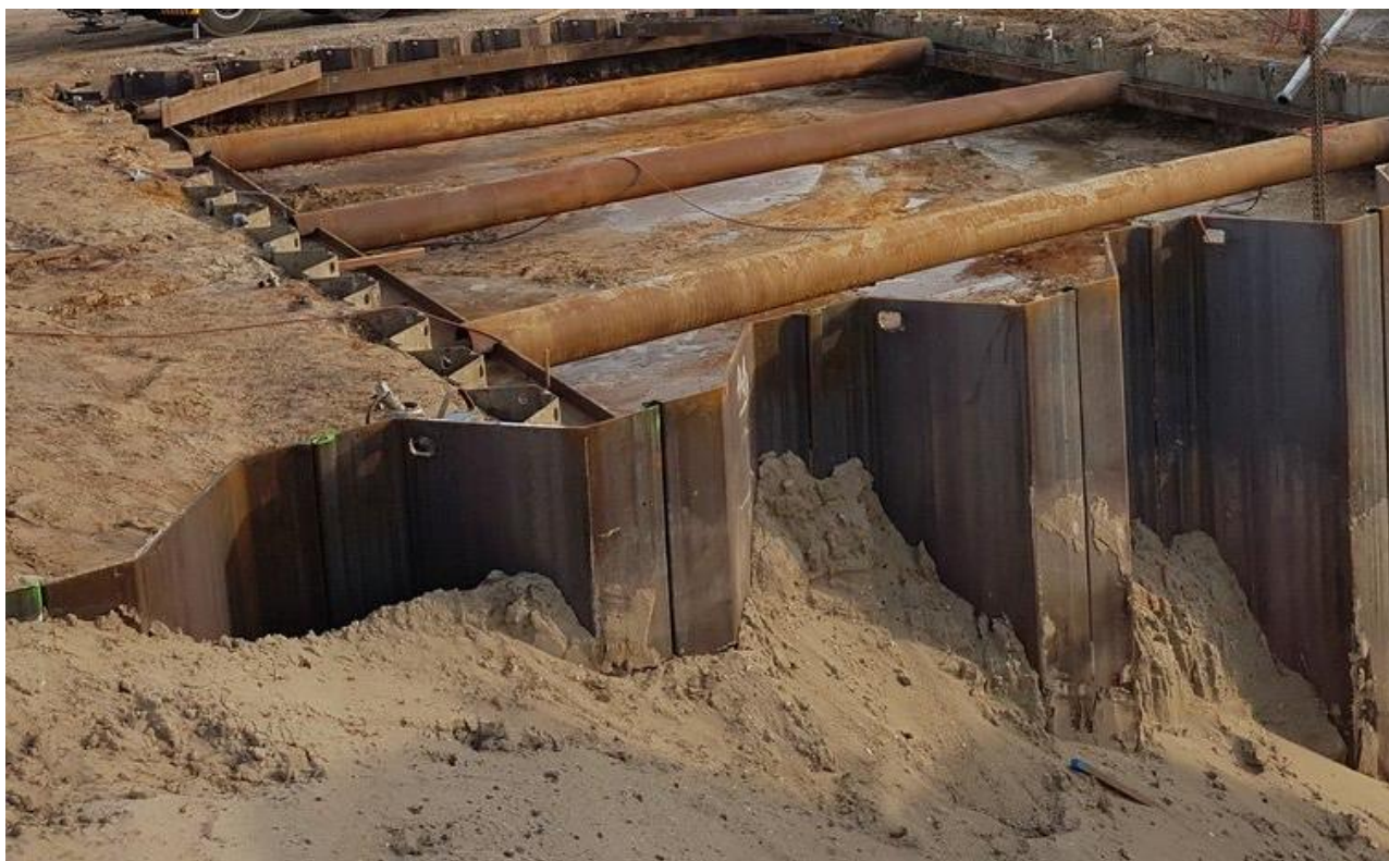
Figuur 5 Voorbeeld van geplande stalen damwand (tijdens de bouw)
