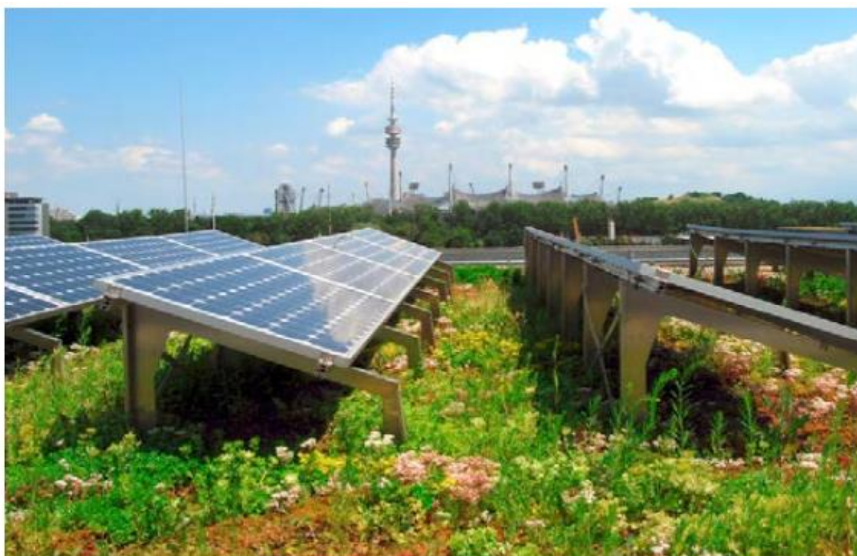
Zonnepanelen geïntegreerd op een groen dak.
