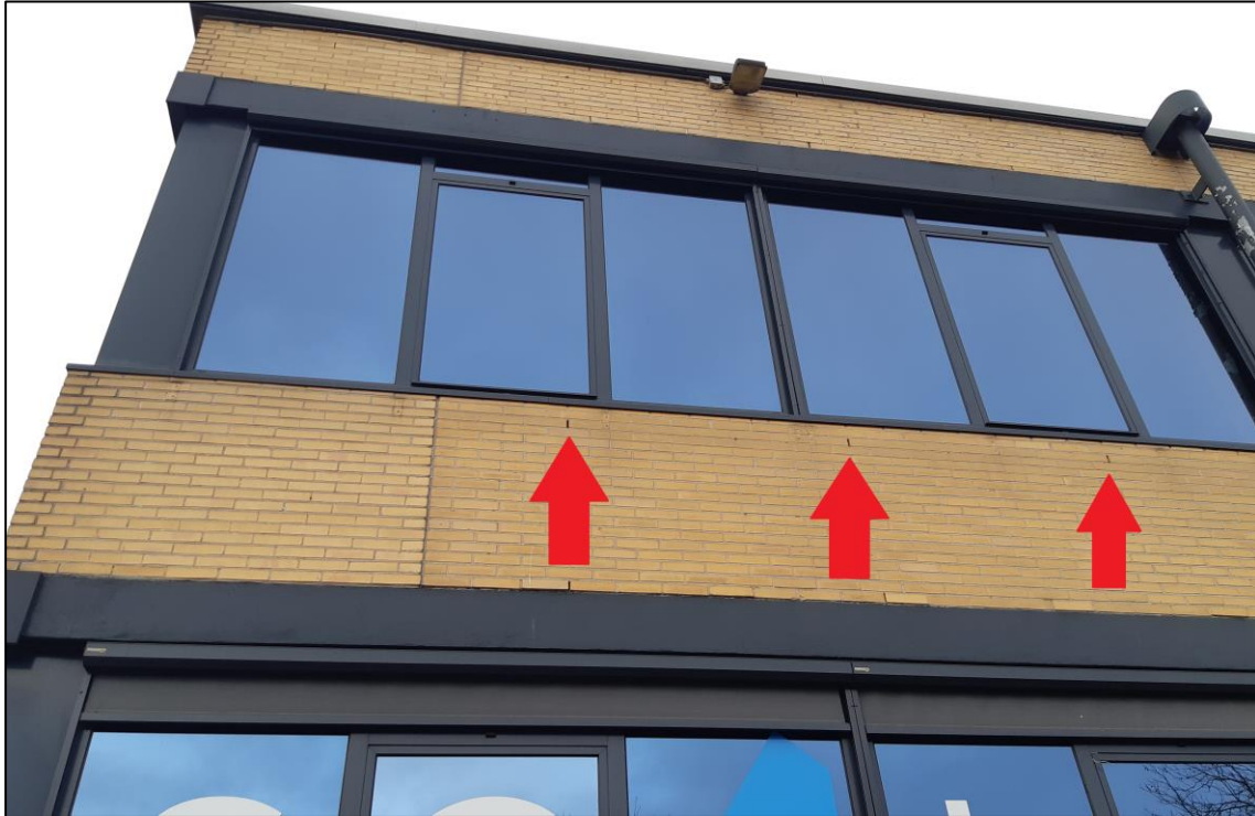
Figuur 4.1 Spouwmuur van het kantoorpand met potentiële vleermuisverblijfplaatsen bereikbaar via de open stootvoegen (rode pijl). Foto: D. Pruijs, Ecogroen.
