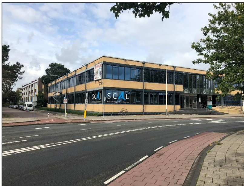
Figuur 1.1: Bestaand gebouw
