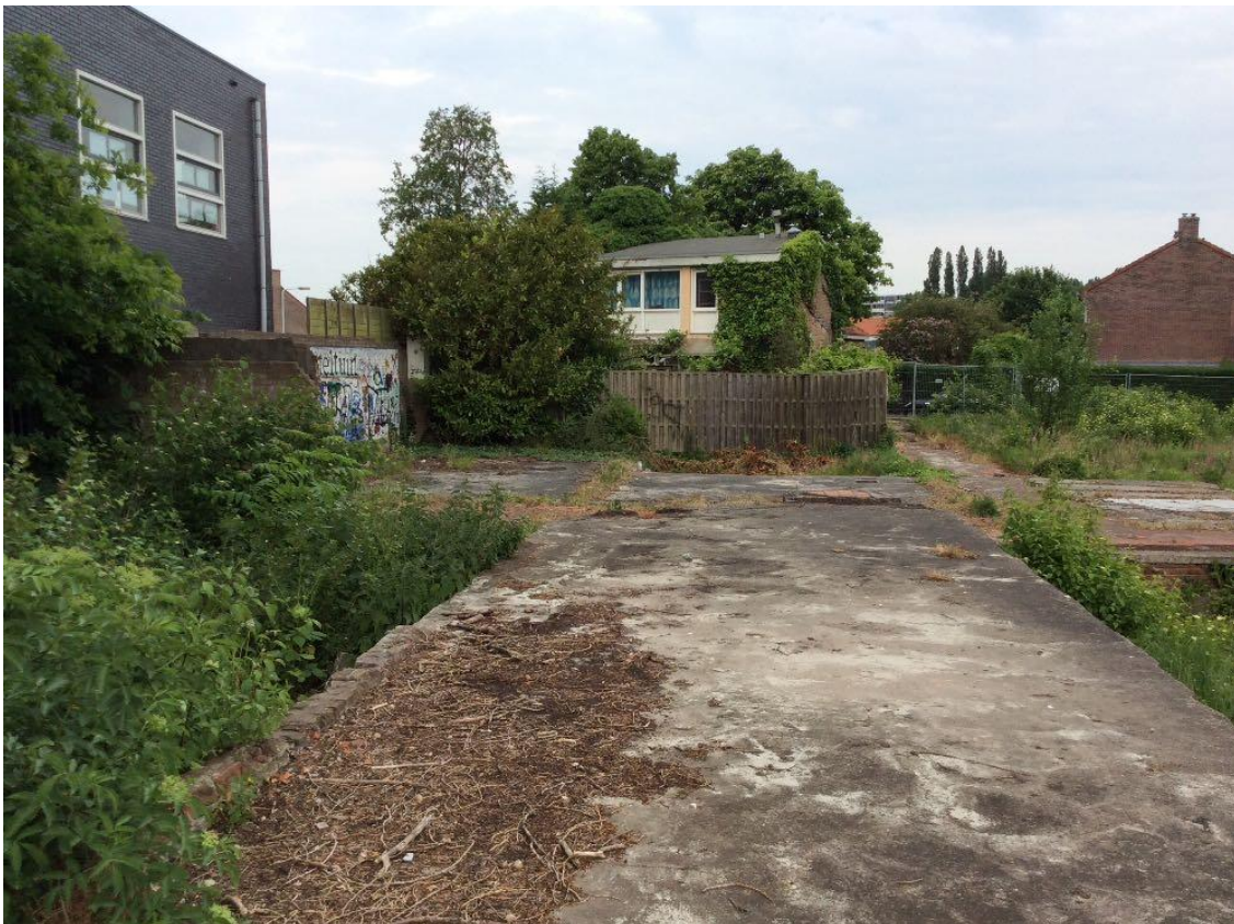
Foto 10 Totaaloverzicht fundamenten, zuidkant locatie
