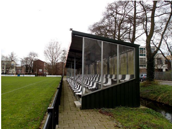
a) tribune aan Teldersweg
