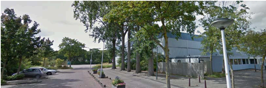
Foto 1 overzicht van de onderzoekslocatie, parkeerterrein sporthal
