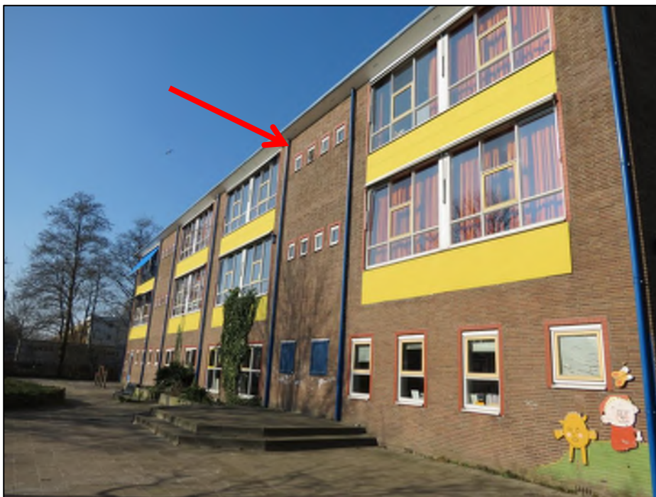
Figuur 3. Zuidgevel van het schoolgebouw met de beschermde situaties. Met rode pijl geduid de locatie met met verblijfplaats van Gewone dwergvleermuis.
