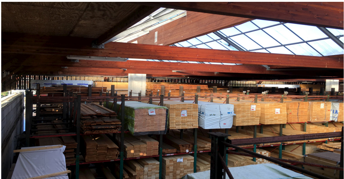
De loods aan de binnenzijde
