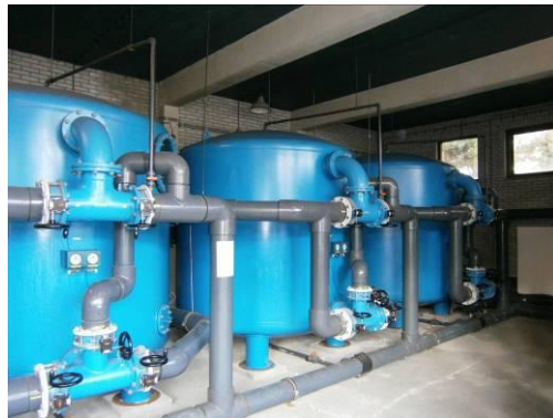
E. Machinegebouw, interieur
