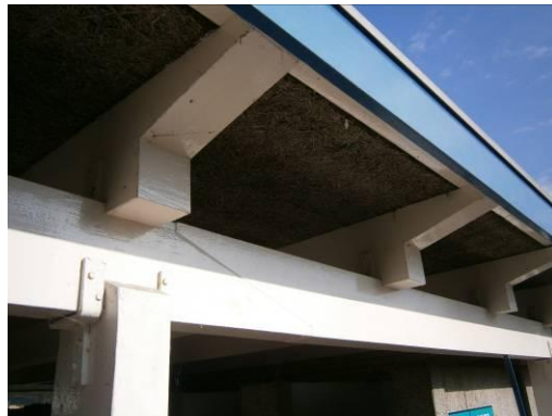
B. Kleedruimte-west, detail constructie
