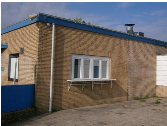
A. Hoofdgebouw, overgang oud-nieuw
