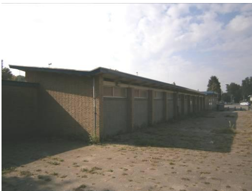
B. Kleedruimte-oost, noordgevel
