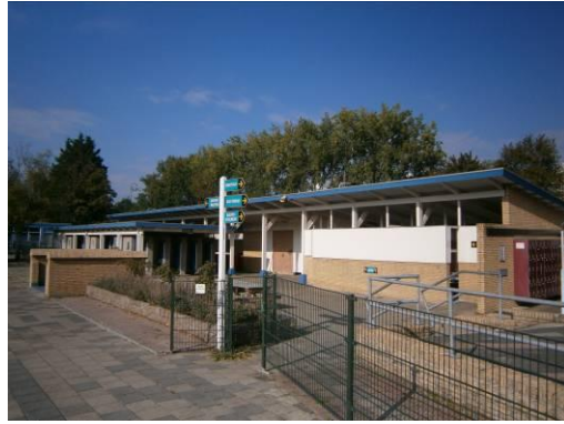
B. Kleedruimte-west, zuidgevel
