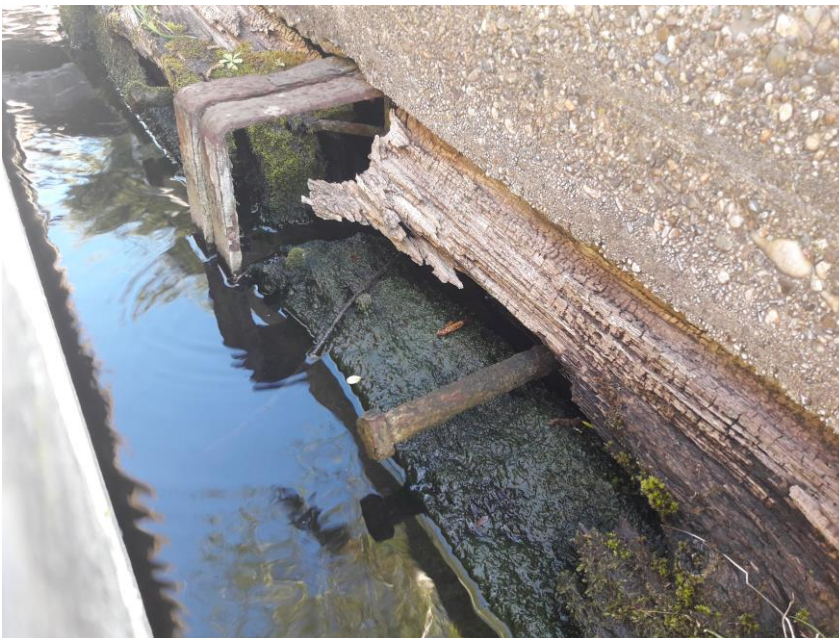
Figuur 4: anker Gording
