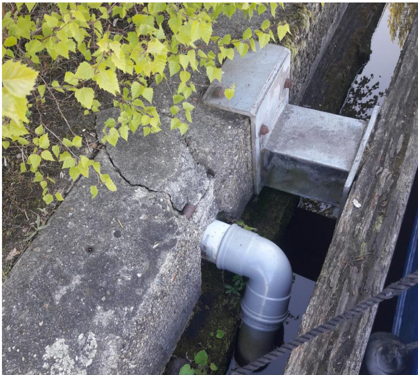
Figuur 2: Doorvoer in deksloof
