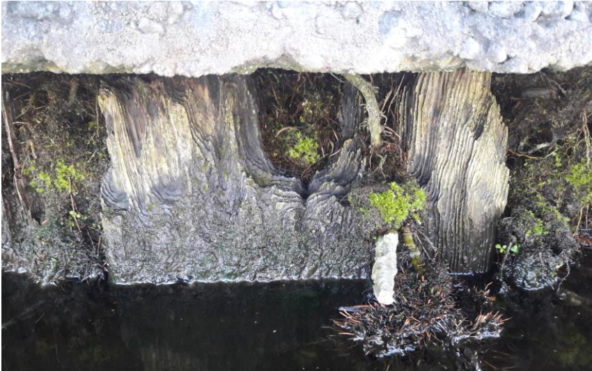
Figuur 5: bestaande damwand (deel boven water)
