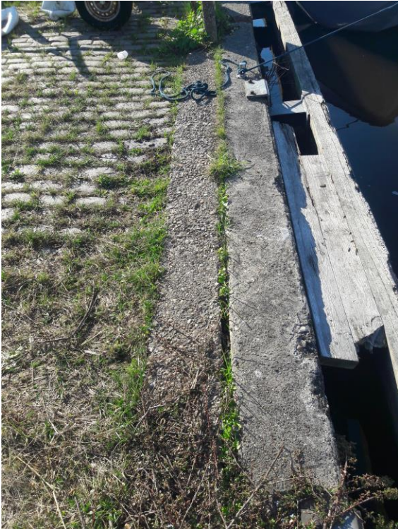
Figuur 3: Betonnen deksloof met daarachter betonnen rand
