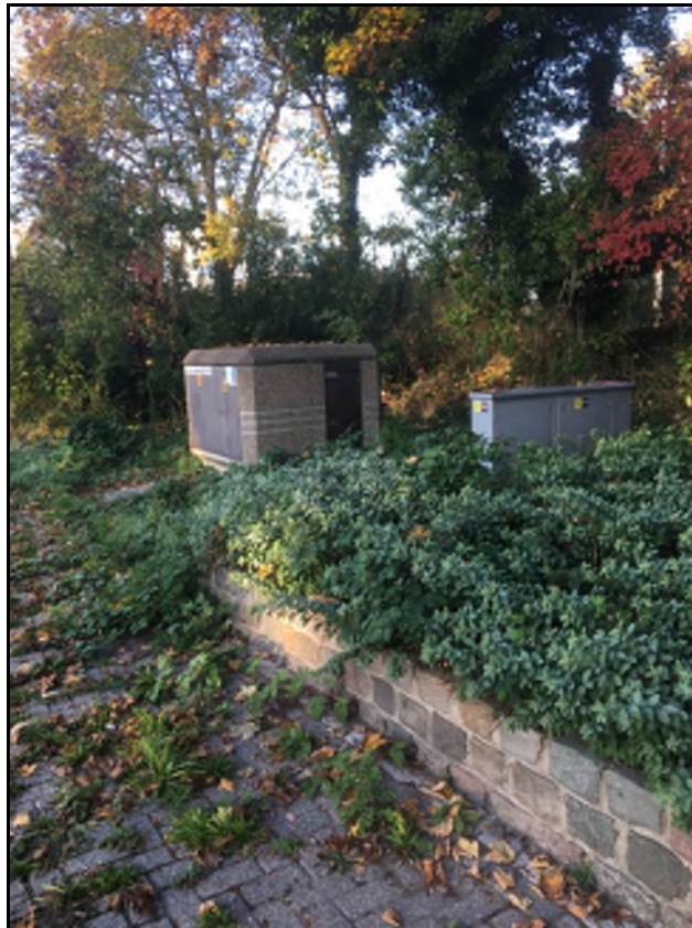
Figuur 9. Gasstation en elektriciteitskast in de aanwezige bosschages.
