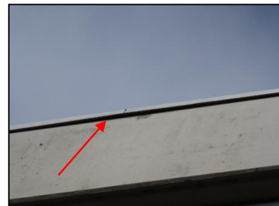
Figuur 13. Geschikte opening voor vleermuizen.
