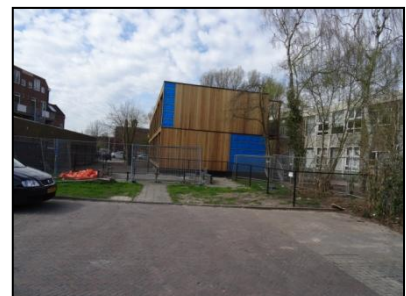
Figuur 8. Overzichtsfoto oostzijde. In het midden de woonunits en aan de rechterzijde de school.
