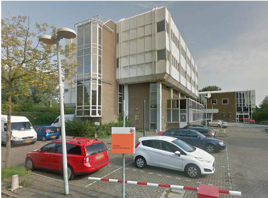
Figuur 2 Het bestaande bedrijfspand
