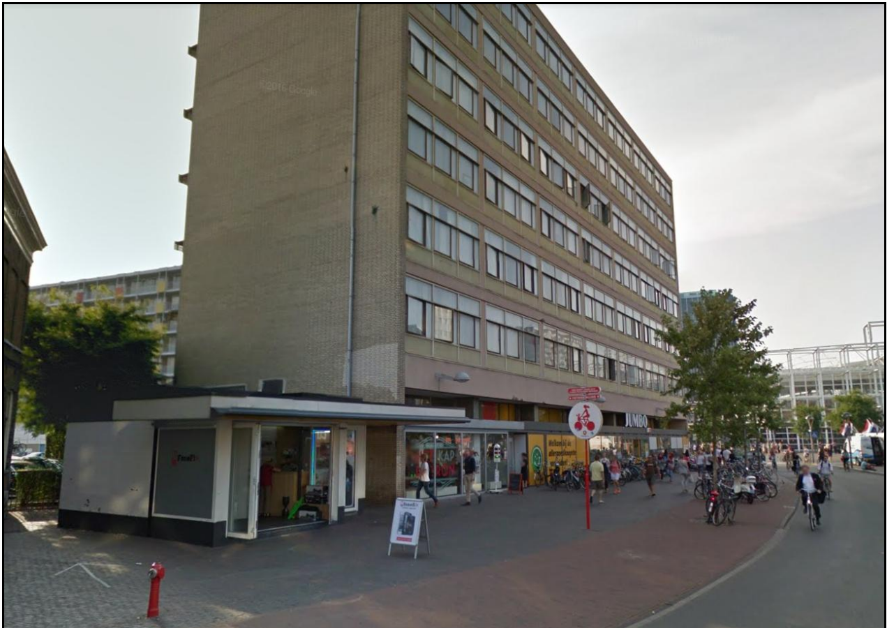
Figuur 16. Het YNS-pand gezien vanaf de Stationsweg. (Bron: Street View, september 2016).
