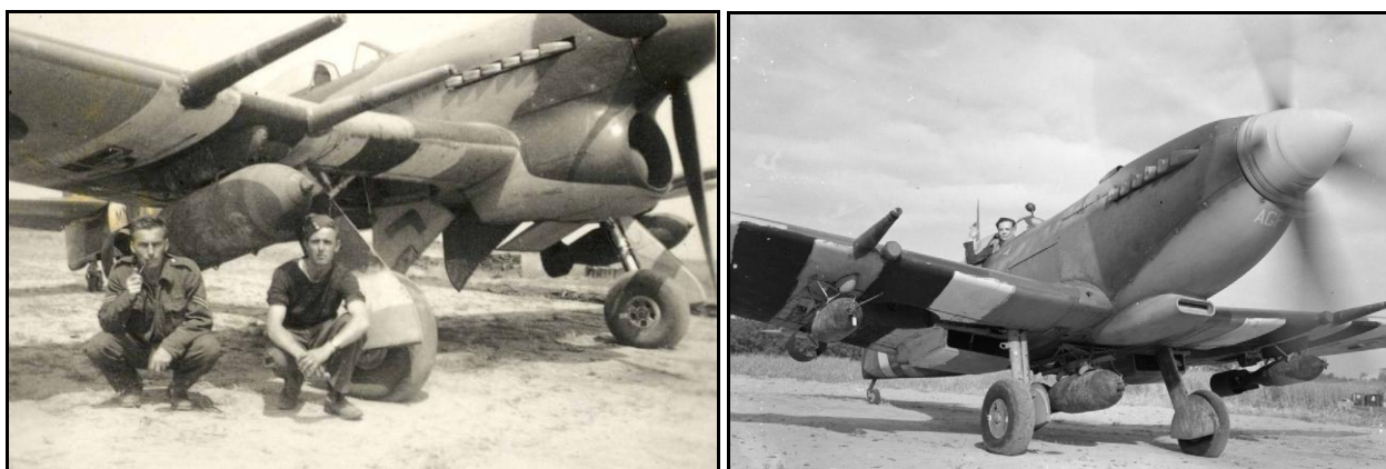
Figuur 18. Britse 1000 lb. MC bommen opgehangen onder de vleugels van een Hawker Typhoon jachtbommenwerper (links). De Super Marine Spitfire jachtbommenwerper (rechts) is voorzien van twee 250 lb. bommen onder de vleugels en één 500 lb. MC bom midden onder het vliegtuig.
