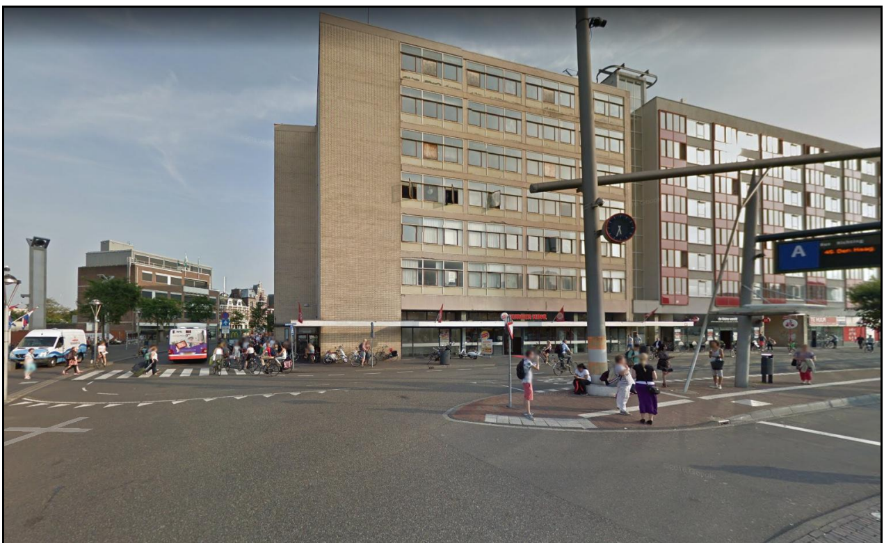
Figuur 17. Het YNS-pand gezien vanaf het Stationsplein. (Bron: Street View, september 2016).
