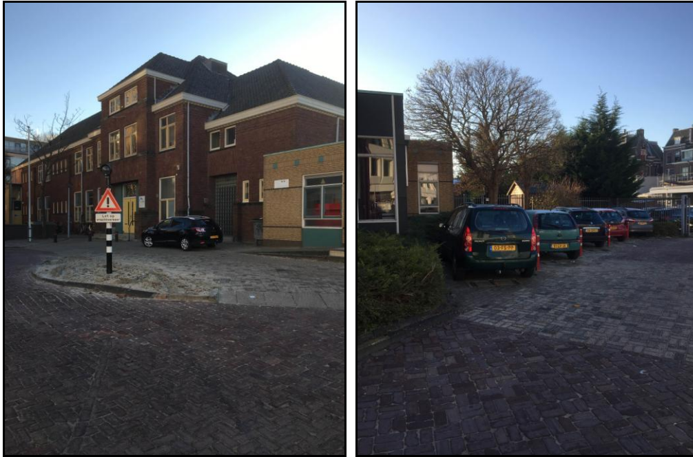
Figuur 16. Het schoolgebouw aan het Ballonpad (links) en het bij het schoolgebouw gelegen verdachte gebied (rechts).
