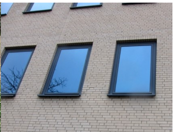
f) open stootvoegen boven de ramen
