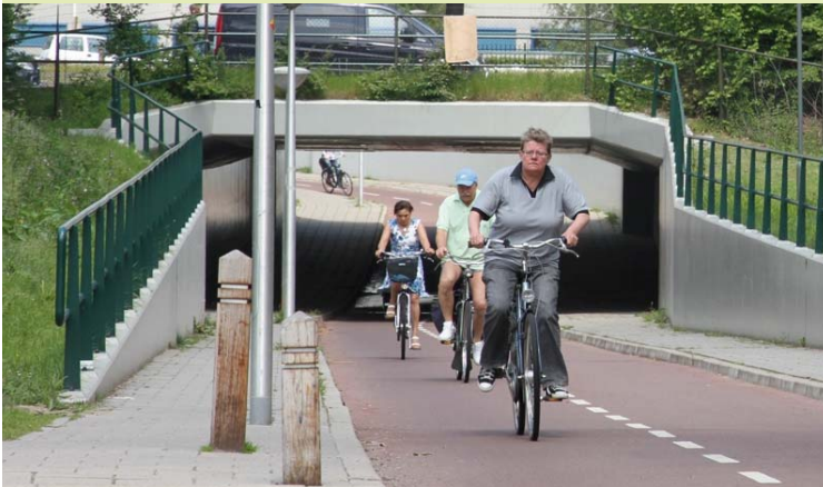
referenties ondergronds deel tunnel
