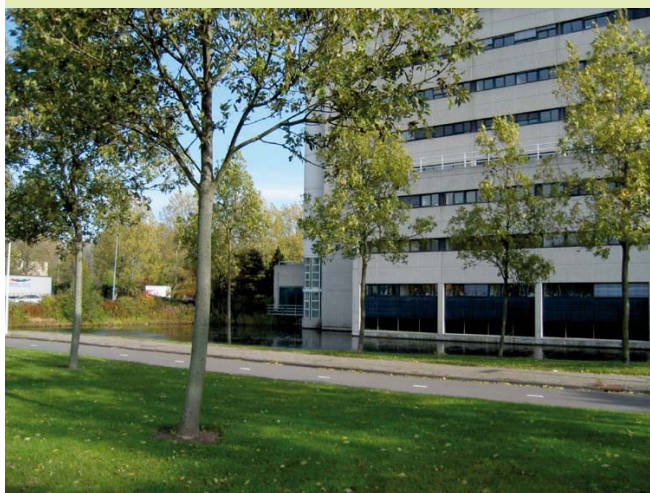
bebouwing in relatie tot de openbare ruimte
