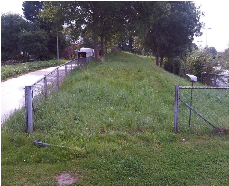
Foto 1 Zuidzijde van de geluidswal. Links is het fietspad zichtbaar.
