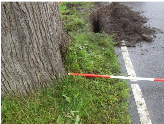
Foto 8 afstand van stamvoeten tot aan het asfalt ca. 0,5 m.
