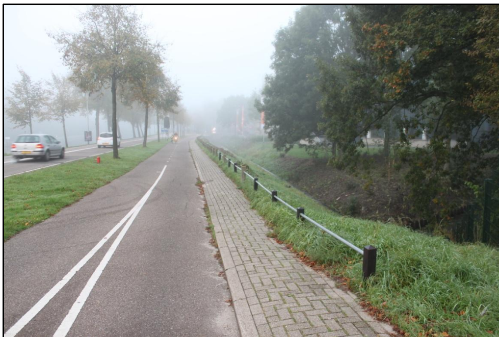
Figuur 24. Hekwerk en damwand langs fietspad aan westzijde van spoorlijn.
