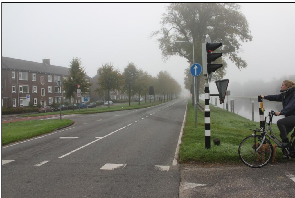
Figuur 28. Kwetsbare infrastructuur zoals de woningen aan de Kanaalweg
