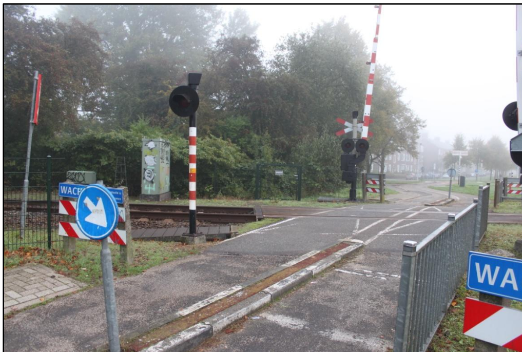
Figuur 23. Detectiebeperkende infrastructuur aan de noordwest zijde van de spoorwegovergang.
