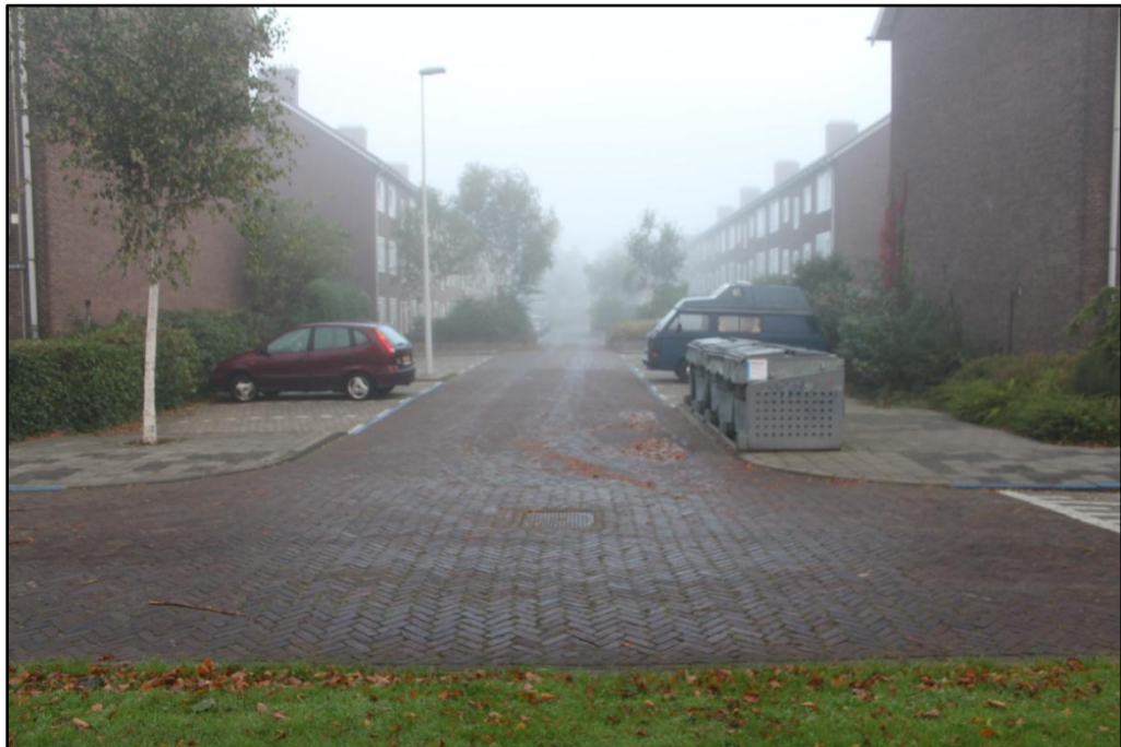
Figuur 25. Het wegdek met zichtbaar een rioolput in de Temminckstraat.
