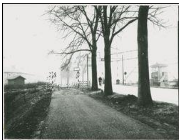
Figuur 13. Gezicht op de aanleg van het fietspad langs de Kanaalweg in 1958 ter hoogte van de spoorwegovergang in de lijn Leiden – Utrecht. (Bron: Regionaal Archief Leiden)
