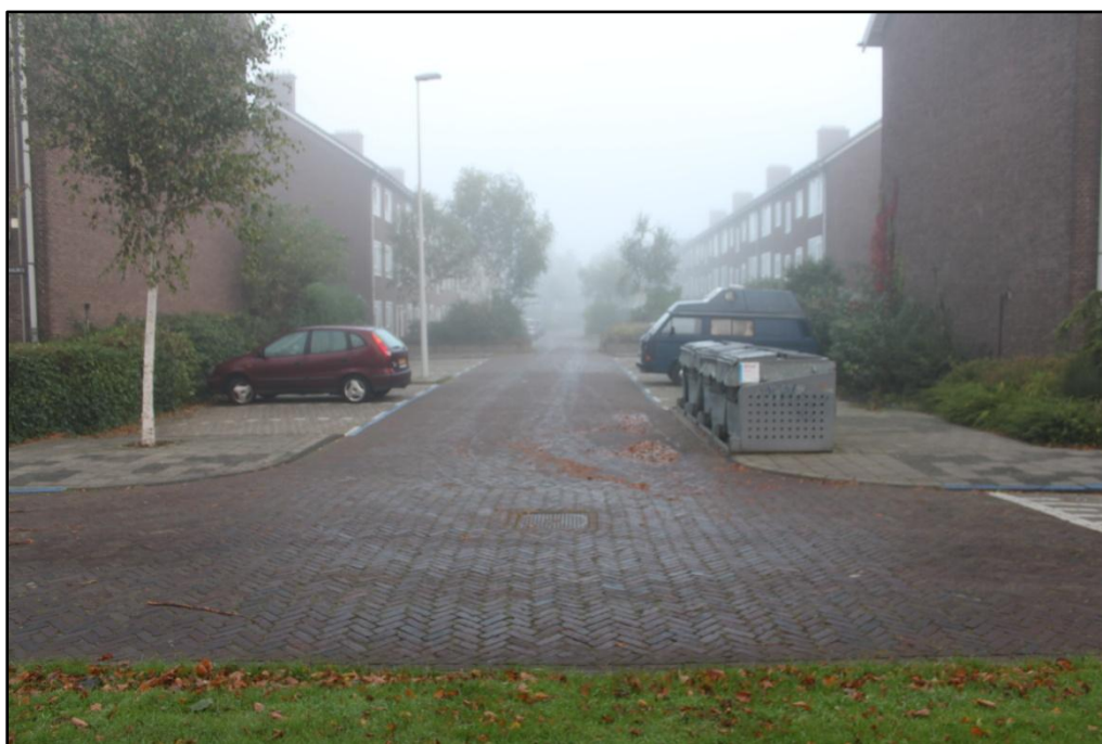
Figuur 29. Kwetsbare infrastructuur op de hoek Temminckstraat – Kanaalweg.
