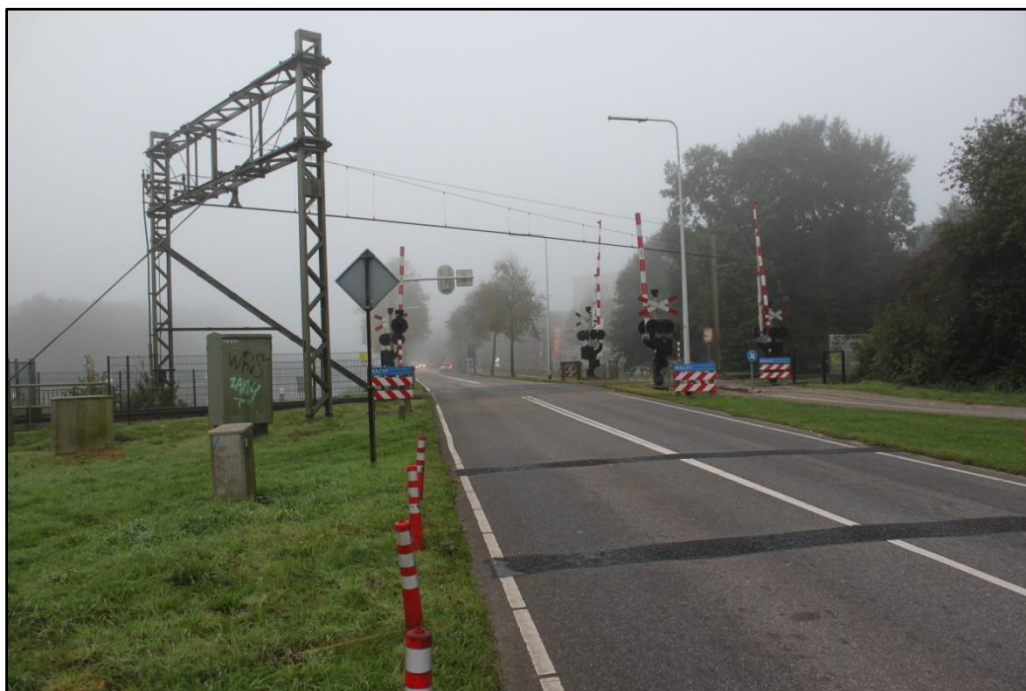
Figuur 21. De spoorwegovergang in de Kanaalweg gezien vanuit het oosten.
