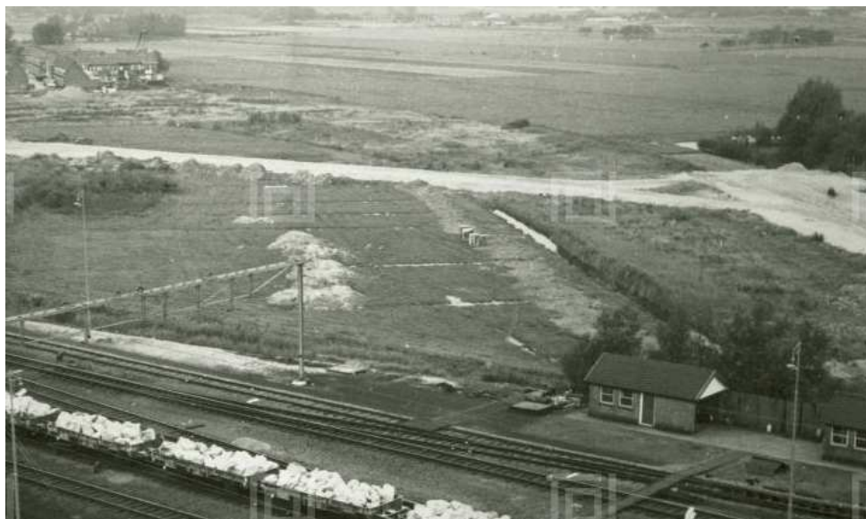
Afbeelding 2: voorbereidingen bouwrijp maken medio jaren 60
