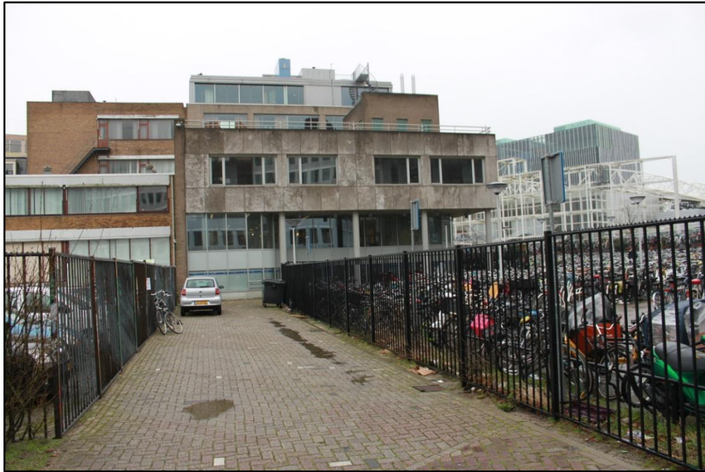
Figuur 22. Te slopen panden, gezien in zuidwestelijke richting vanaf het Ballonpad. Rechts is een gedeelte van de tijdelijke fietsenstalling zichtbaar.
