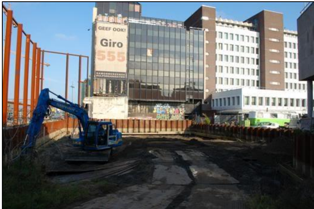
Figuur 14. Damwandkuip van het zgn. "Gat van Van der Putten" (Bron: onbekend).
