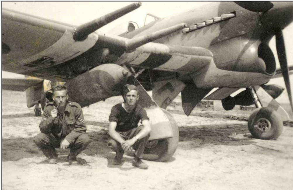
Figuur 5: Britse 1000 lb. MC bommen opgehangen onder de vleugels van een Hawker Typhoon jachtbommenwerper (Bron: http://vetvoicecan.org ).
