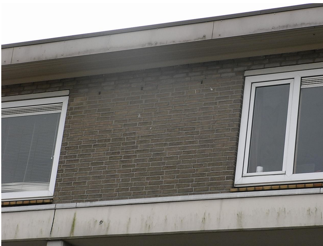
Foto 17: Detailopname open stootvoegen
