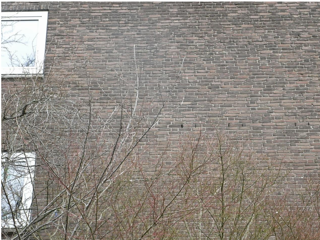
Foto 9: De open stootvoegen aan de kopse kant van de laagbouw aan de Bernhardstraat
