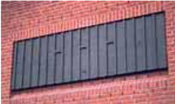
Afbeelding 8: Voorbeeld van een keramische plaat op een nis in de muur.
