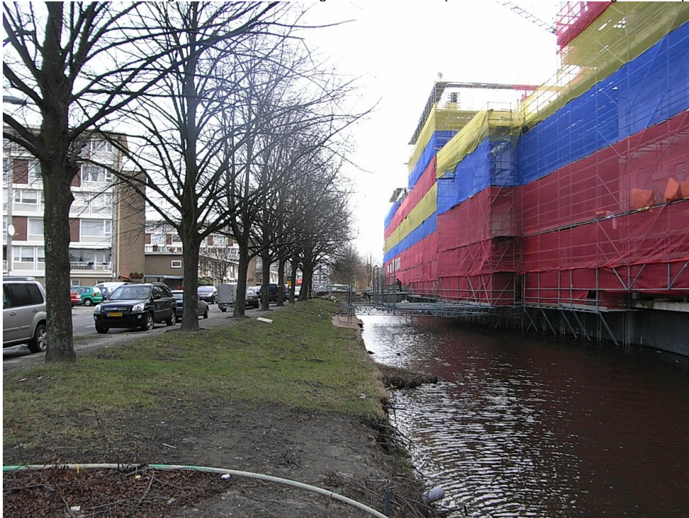
Foto 29: 'Het gebouw' aan de Surinamestraat. De oever aan de straatzijde is weliswaar onbeschoeid, maar enige dekking in de vorm van oeverbegroeiing ontbreekt geheel, waardoor deze omgeving niet geschikt is voor libellen, reptielen en amfibieën. Bovendien ligt het water volledig in de schaduw waardoor het nagenoeg niet opwarmt.
