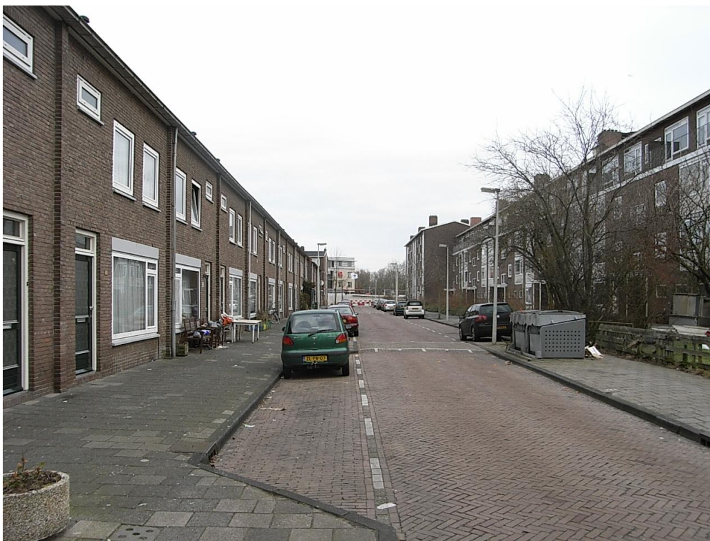
Foto 7: Straatbeeld Bernhardstraat met rechts de te slopen woningen
