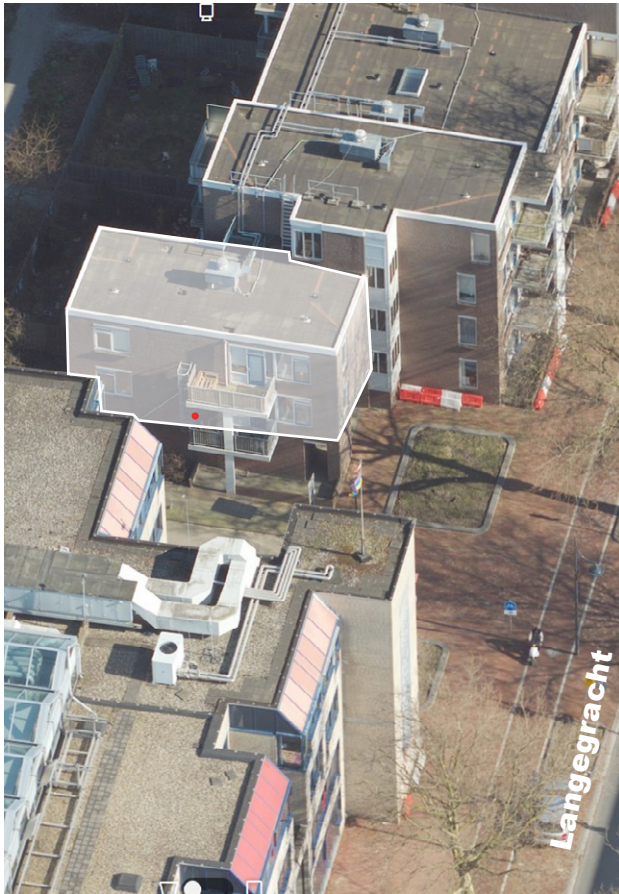
Meetpunt Westgevel Langegracht 76-214
