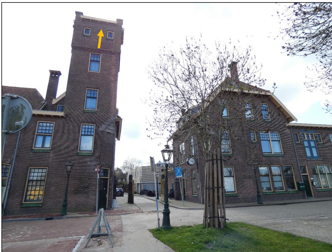
Figuur 24: De toren van het gebouw aan de Noorderstraat 21 (links op de foto) heeft spleetvormige openingen onder het dakoverstek. Hier kunnen gierzwaluwen en algemene broedvogels tot broeden komen. Rechts op de foto is de woning aan Noorderstraat 12- 14 te zien.
