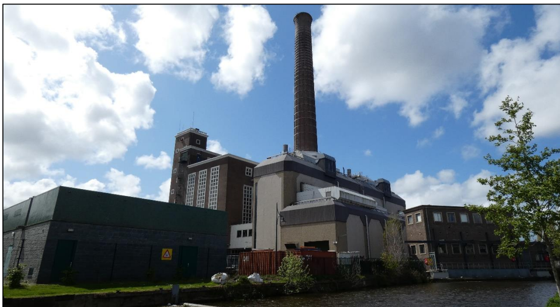
Figuur 7: Energiecentrale .Uniper gezien vanaf de Maresingel.
