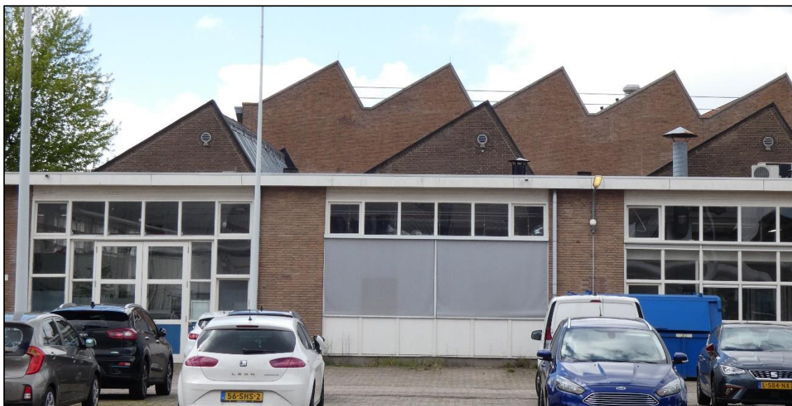
Figuur 4: Het lage bedrijfsgebouw aan Papegaaisbolwerk. De achterste gevelpunten zijn van het Nieuwe Energiegebouw.
