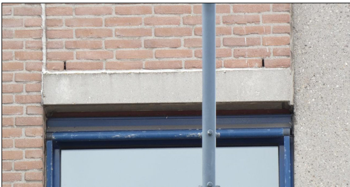
Figuur 31: De open stootvoegen van het PLNT/ Sleutelgebouw zijn niet ruim genoeg voor grotere vleermuissoorten als de laatvlieger om toegang tot een verblijfplaats in de spouwmuur te hebben.
