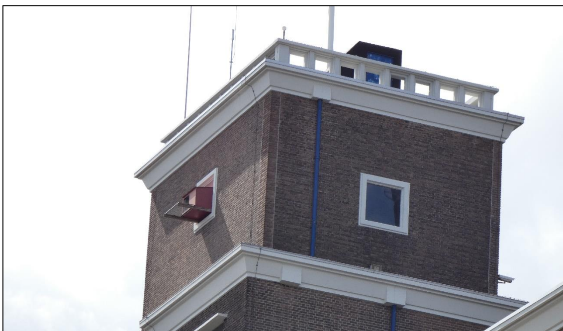
Figuur 27: De slechtvalkenkast aan de toren van de energiecentrale is al jaren in gebruik.
