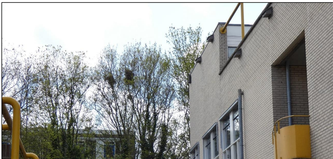
Figuur 25: Twee eksternesten achter basisschool De Pionier (buiten plangebied). Aan dit gebouw zijn eveneens vleermuskasten en nestkasten voor huismus aanwezig. Zes van de huismuskasten waren ten tijde van het veldbezoek in gebruik door huismussen.
