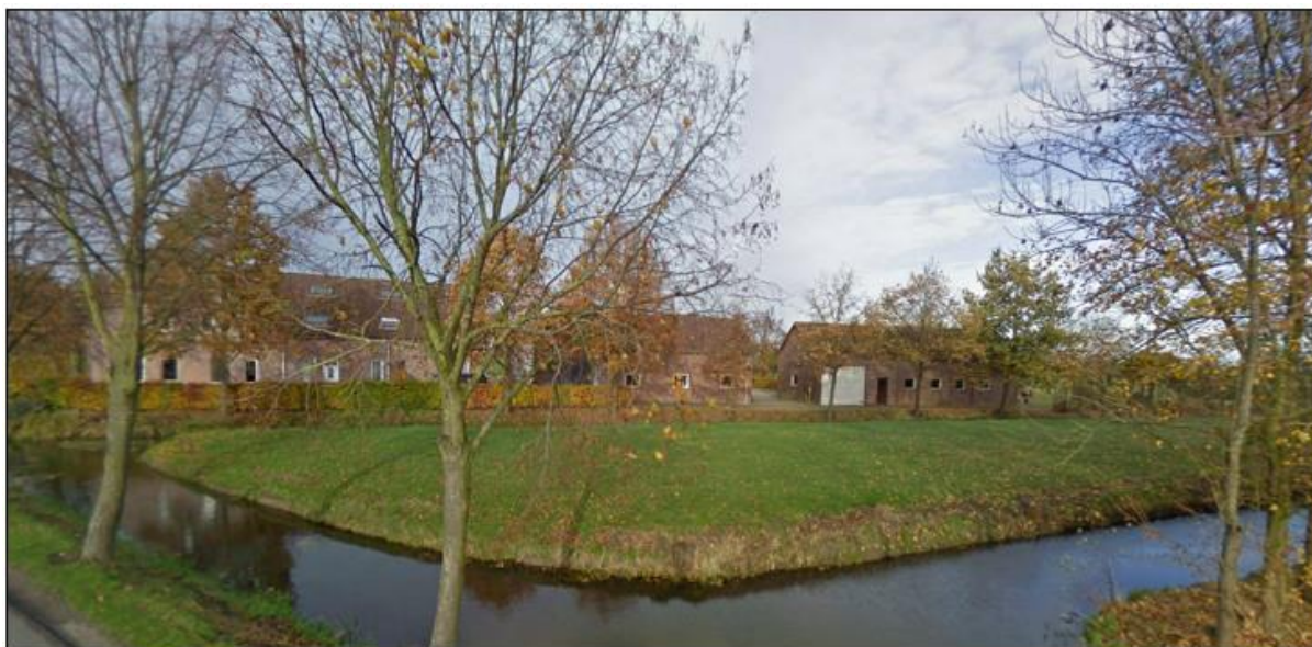
Afbeelding 2.2 Foto aanzicht projectgebied zuidzijde vanaf de Recht van Ter Leede (Bron: Google Streetview)
