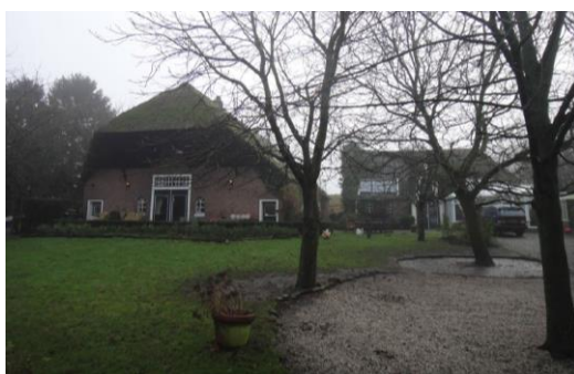
Boerderijwoning annex vakantiewoning met naastgelegen bijgebouw, gezien van achtererf
