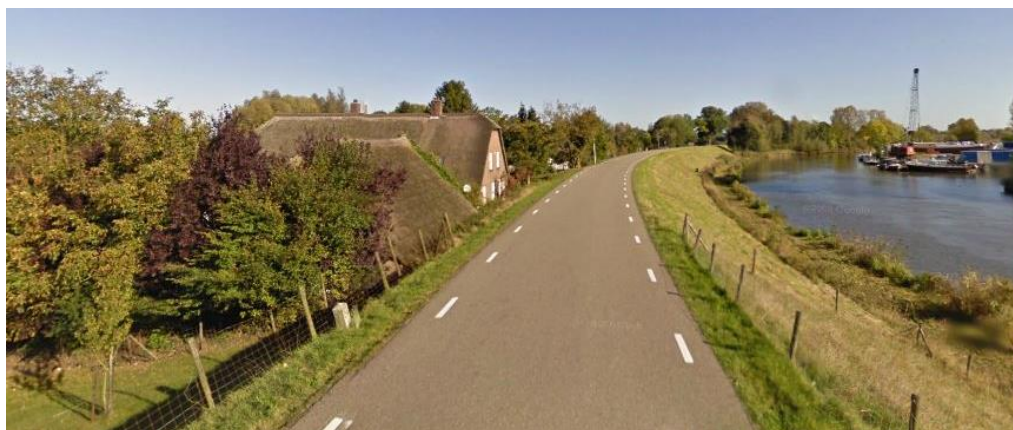
Locatie Lingedijk 111 Kedichem, gezien vanaf de Lingedijk – kijkrichting in noordelijke richting. Ligging plangebied in het Buitengebied van de gemeente Leerdam
