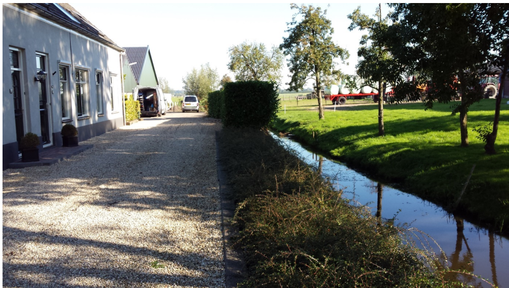
Figuur 2 Het woonhuis verkeert in matig tot goede staat van onderhoud en is onbewoond.
