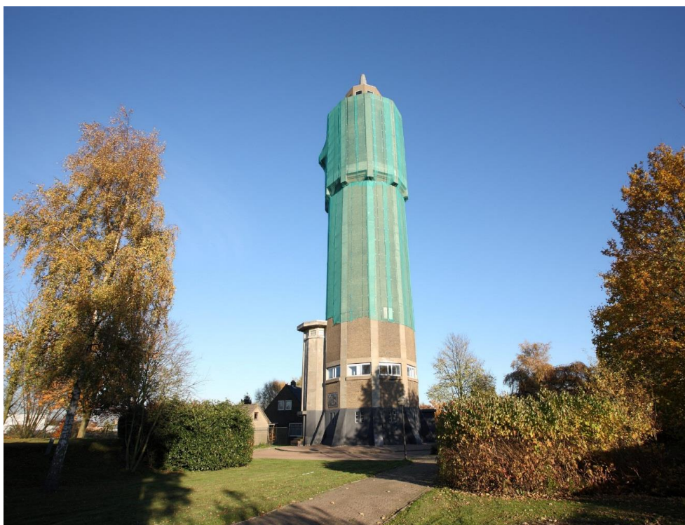
Afbeelding 4: Bestaande situatie plangebied
