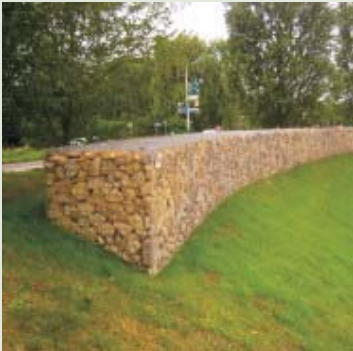
Opvang deel talud middels schanskorf
